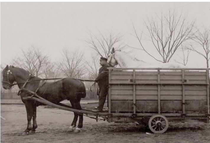
Djurtransportvagnen användes för att transportera sjuka eller skadade djur.
