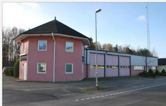
Stationens framsida har tre portar. Tornbyggnaden utgör personalutrymmen och kontor. Kommunal verksamhet i borte delen, med port mot baksidan. Foto: Lars-Owe Göthe
