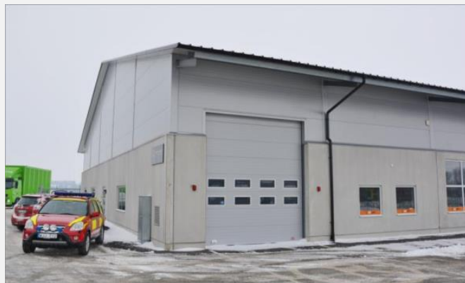
Stationen har en port och är placerad i en del av en företagsbyggnad.
