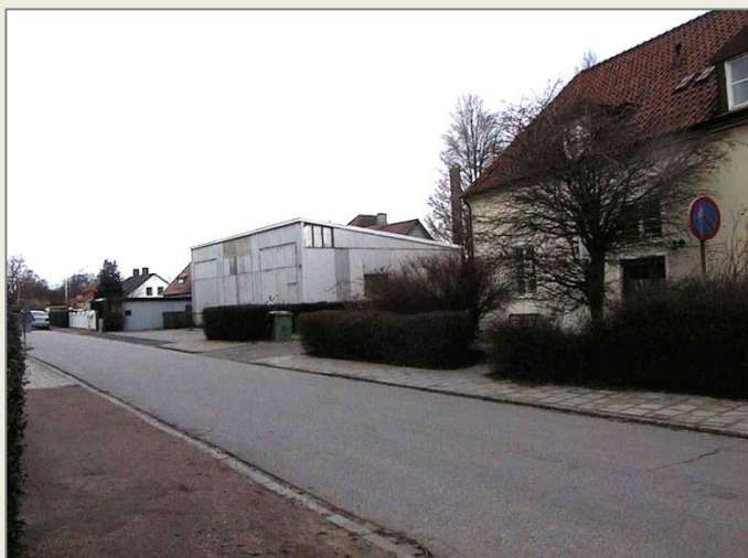
Plåtgaraget förföll och i samband med att stationen byggdes om för ny verksamhet revs garaget och en parkeringsplats anlades.
