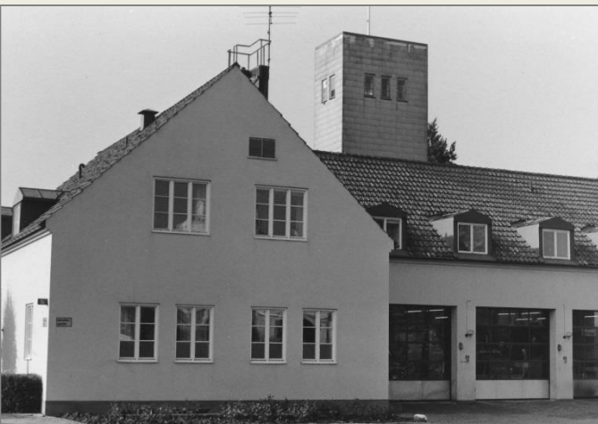
Slangtornets trä- och eternitbeklädning byttes senare ut och hela tornet putsades.
