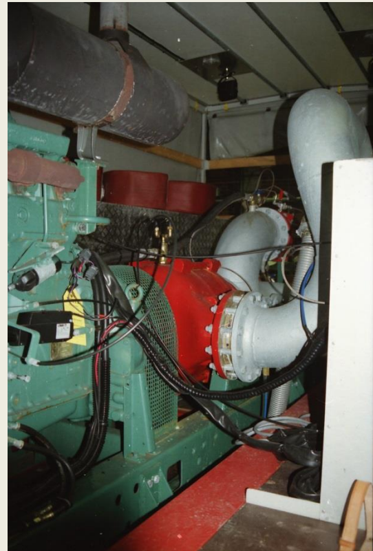
Pumpens drivmotor med kylaranläggning framåt och avgasrör uppåt genom kapelltaket.
