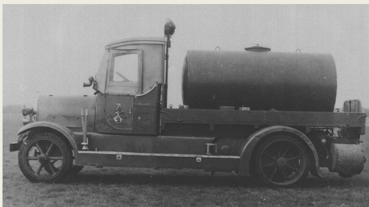
Under slutet av 40-talet ersattes påbyggnaden bakom hytten av ett flak och en vattencistern
