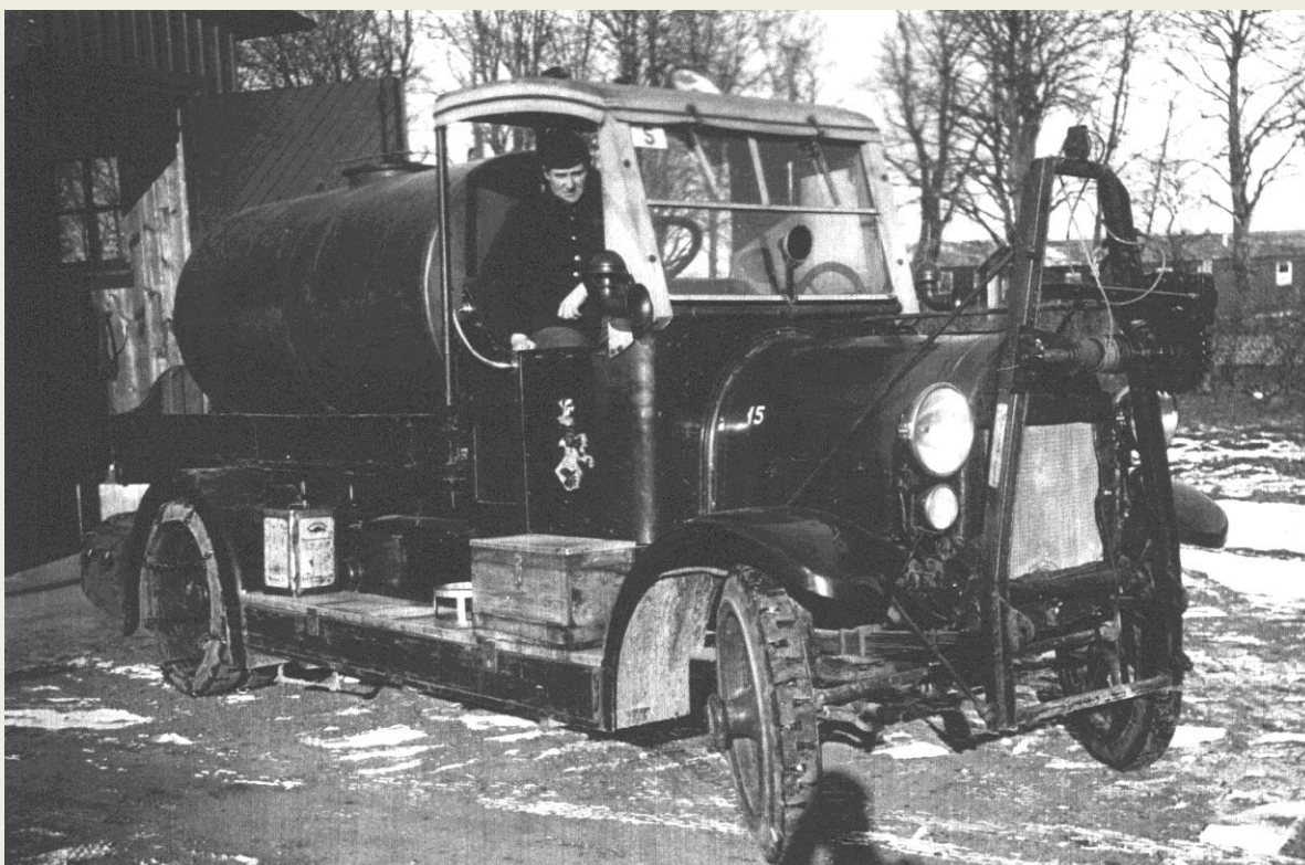
Under de snörika vintrarna på 40-talet monterades ett fäste för snöplog på bilen. Bilen stod mot slutet i depå på Bulltofta, där bilden nedan är tagen.
